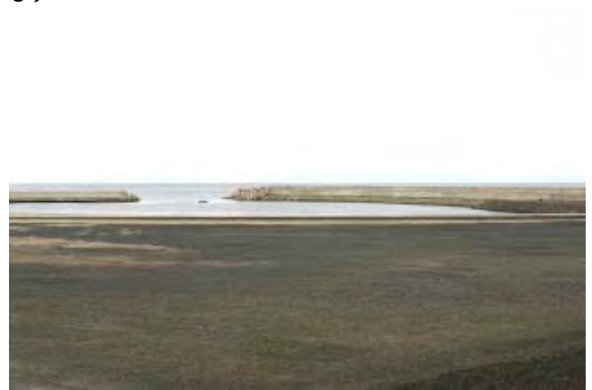
●月崎海岸「横綱ビーチ」建設中
