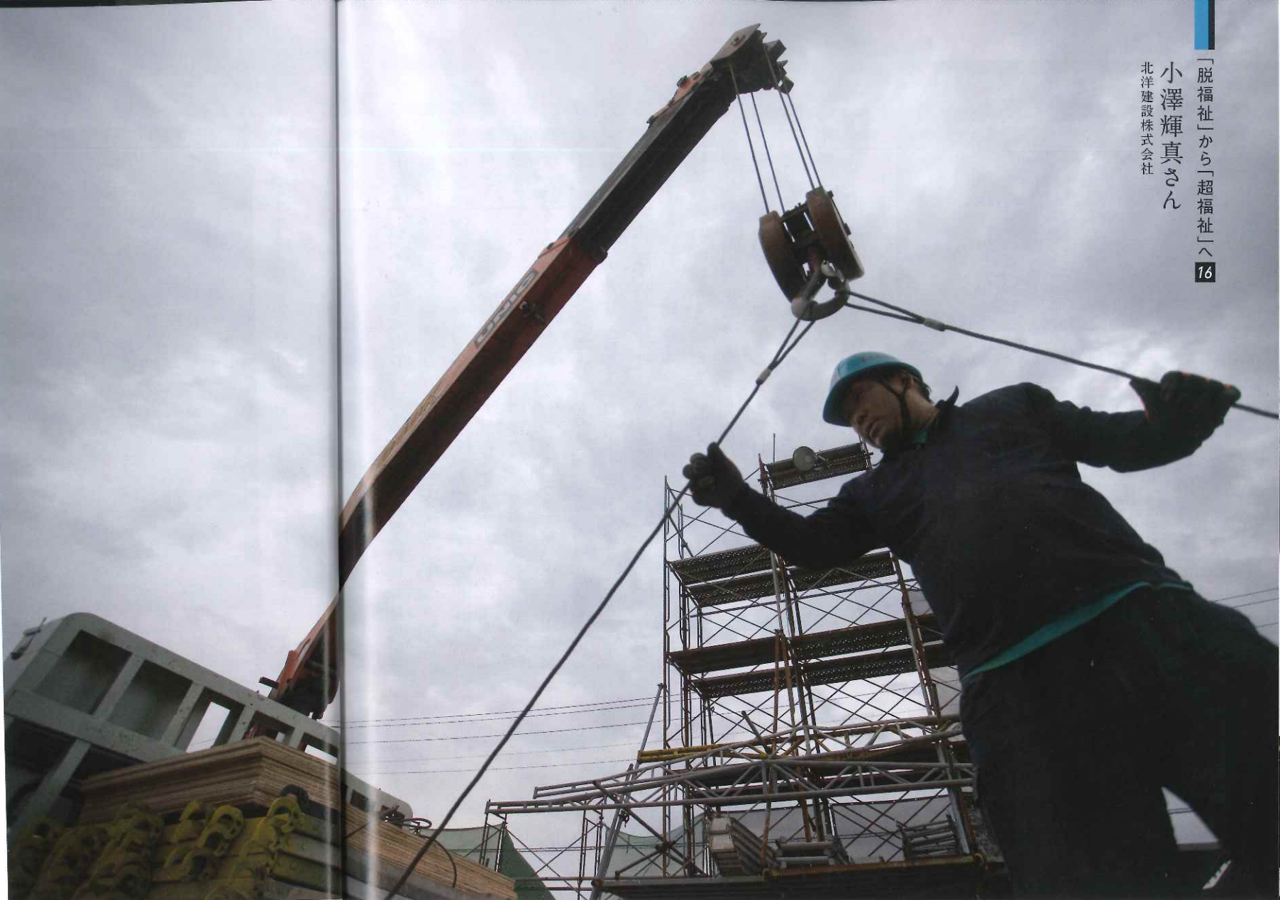
足場板の荷卸しをする荒川和也さん。
