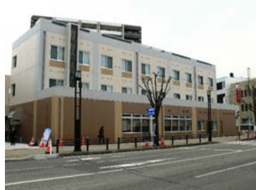
高齢者住宅棟
